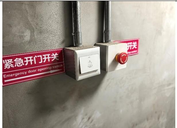
3# 人员防护门紧急开门开关、急停开关
