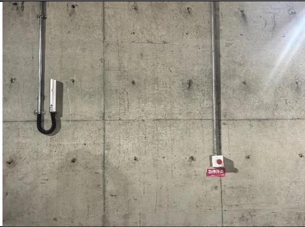
4# 在线剂量探测装置、急停开关
